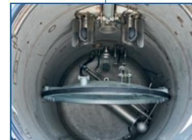
Hydraulisch klappbare Trennwand. ROTOMAX Wasserrückgewinnungssystem.
